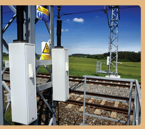
Elektroline a.s. provádí výrobu a montáž motorových pohonů trakčních odpojovačů určené pro použití se všemi typy používaných úsekových odpojovačů, napáječů a zkratovačů.
