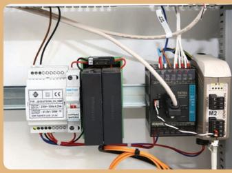
R00 – rozváděč optického oddělení sériového rozhraní R00 – board with optical separation of serial bus interface
