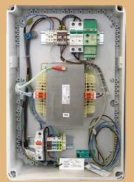
RTR je rozváděč s oddělovacím transformátorem 230 VAC / 230 VAC a výkonu 1kVA vybavený hlídačem izolačního stavu.
