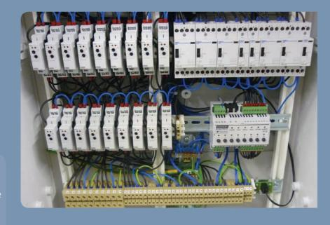
Digitální kontrola proudovými relé DALIcus připojených na sběrnici ESbus umožňuje kontrolu přesných hodnot proudu včetně možnosti nastavení tolerance vyhlášení poruchy. Změřené reálné hodnoty proudů je možné dálkově přenášet a zobrazovat na dispečerských a jiných pracovištích. Díky tomuto lze snadněji diagnostikovat rozsah signalizované poruchy a tedy určit nutnost případného výjezdu servisních pracovníků.
