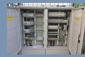
Elektroline a.s. dále provádí výrobu a montáž rozváděčů osvětlení včetně instalace osvětlovacích rozváděčů, svítidel a kabelových rozvodů, rozváděčů elektrických ohřevů výhybek a jiných silových a technologických rozváděčů.
