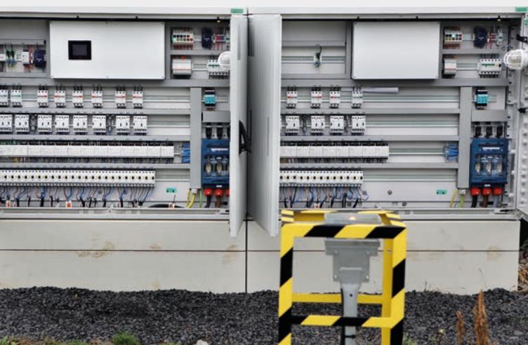
Elektroline provádí výrobu, montáž a servis plně automatického systému elektrického ohřevu výměn. Jeho součástí je přenos všech provozních stavů do dopravních kanceláří a dispečerských pracovišť.
